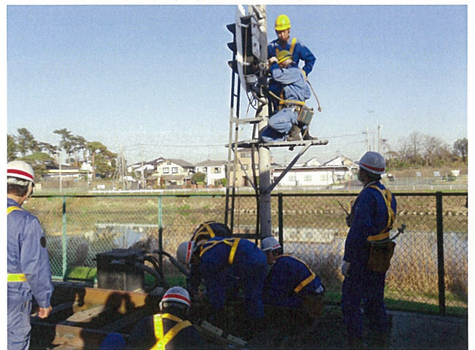
信号機・絶縁装置交換復旧訓練
