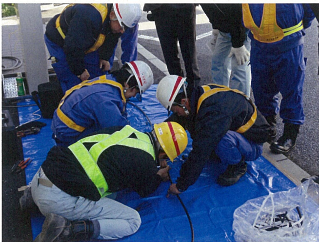
光ケーブル復旧訓練
