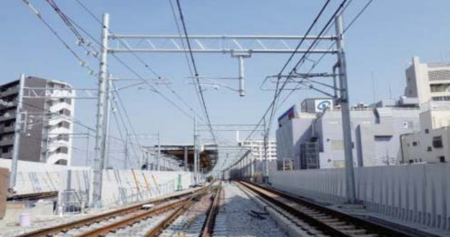
竹ノ塚駅付近高架化工事
