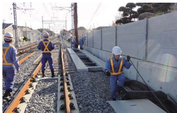
ケーブル敷設工事
