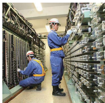
継電器室配線作業
