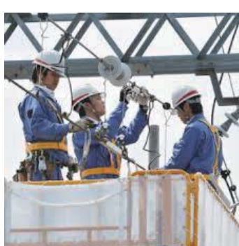
電車線張替訓練
